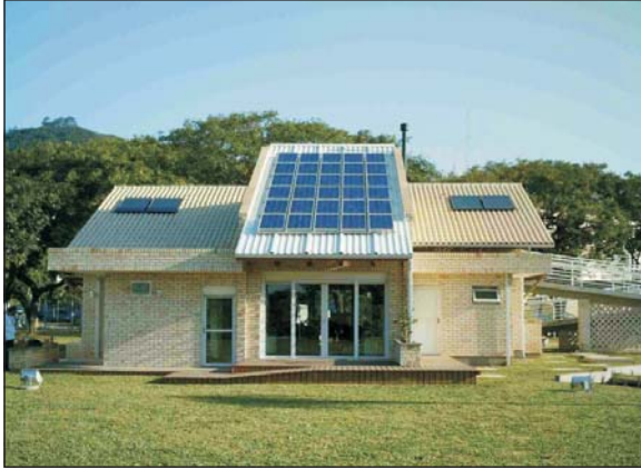
Figura 23: Casa Eficiente com incorporação de painéis fotovoltaicos para produção de energia elétrica funcionando como sistema integrado à rede
