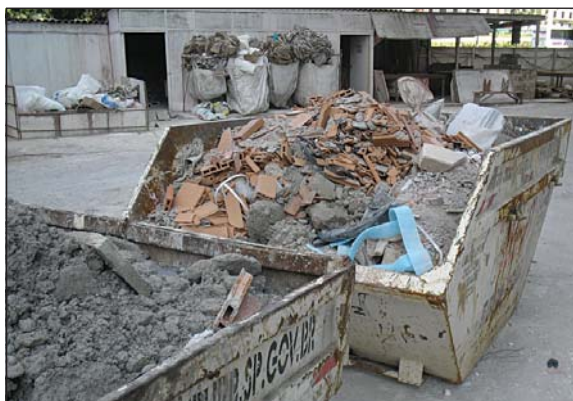
Figura 11: Exemplo de estoque central de resíduos em canteiro, alimentado pelos estoques dos andares. Observar o baixo índice de contaminação dos resíduos classe A, fruto de um programa de educação da equipe.
