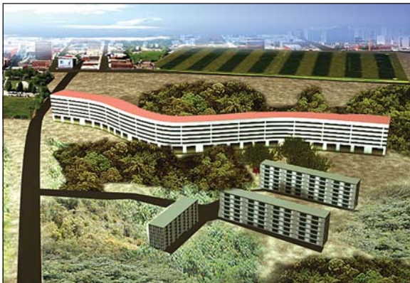
Figura 53: Projeto condomínio Residencial Pedregulho no RJ do arq. Afonso Eduardo Reidy. Ilustração baseada em (BONDUKI, 2002).
