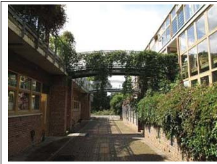
Figura 3: Sombreamento por meio de vegetação. Projeto Bedzed, Inglaterra. Arquiteto Bill Dunster Foto de O. Kucker (imagem cedida pelo autor).
