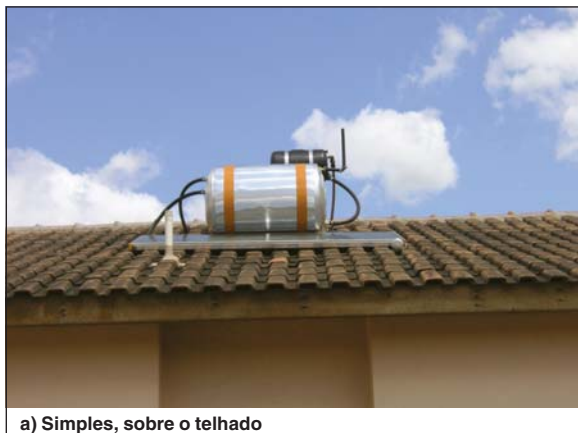
Figura 13: Posicionamento do coletor
