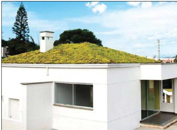
Figura 11: Teto jardim na cobertura de salão de festas de condomínio. Projeto Terra Domus, da Sphera Quattro. Florianópolis Foto (cedida pelo autor).
