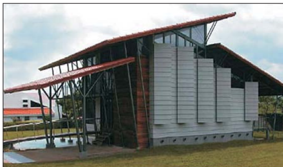
Figura 50: Exemplo de sombreamento. Projeto Casa Rodríguez. Arquiteto Bruno Stagno Costa Rica Fonte: www. brunostagno.info (imagem cedida pelo autor).
