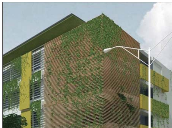
Figura 6: Uso do paisagismo associado ao sombreamento da edificação
