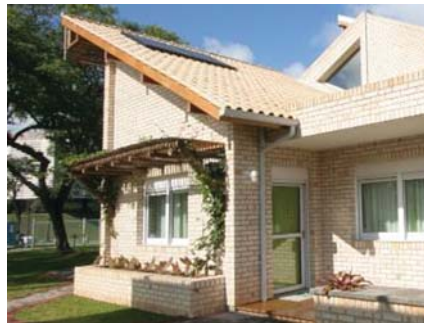
Figura 4: Proteção por meio de pergolado com vegetação na parede leste. Projeto Casa Eficiente. Florianópolis (CASA EFICIENTE) Foto de LabEEEE/UFSC (imagem cedida pelo autor).
