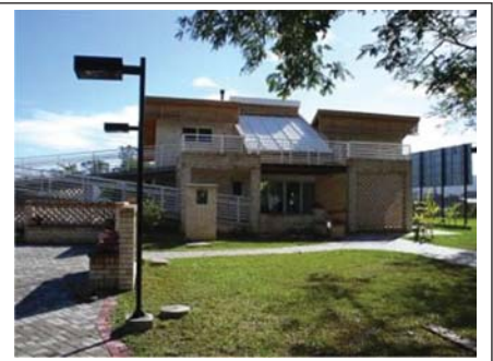
Figura 5: Elementos vazados como redutores de velocidade do vento sul. Projeto Casa Eficiente. Florianópolis (CASA EFICIENTE) Foto de LabEEEE/UFSC (imagem cedida pelo autor).
