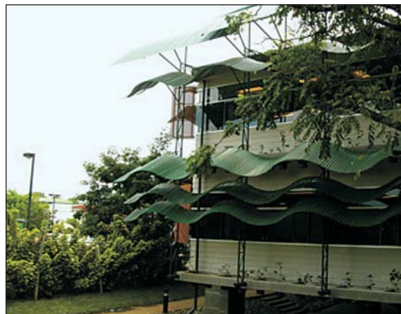
Figura 51: Exemplo de sombreamento. Edifício BAT. Arquiteto Bruno Stagno Costa Rica Fonte: www. brunostagno.info (imagem cedida pelo autor).
