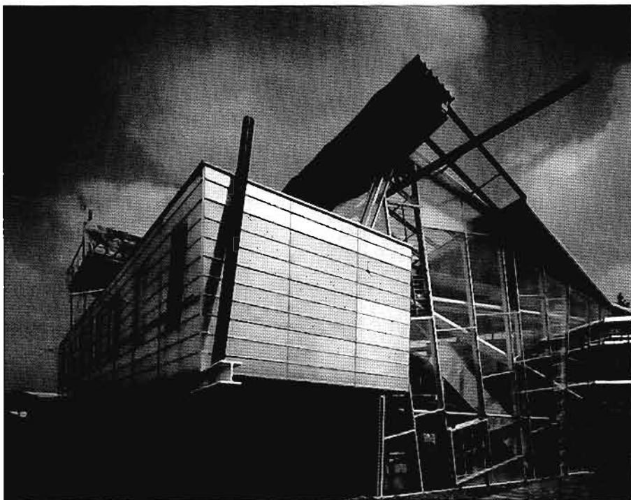
Behnisch & Partner, edifício do Instituto de Investigação Hysolar da Universidade do Estugarda, Estugarda 1987
