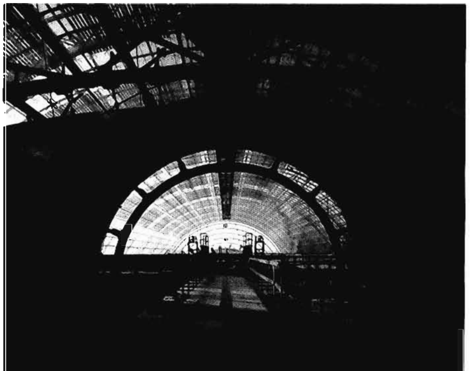
Gerkan, Marg & Partner com H. Nienhoff: pavilhão de feira, Leipzig, começado a construir em 1993.
